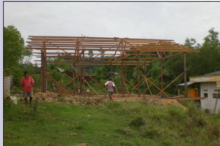
Tahap konstruksi Depo 3R
